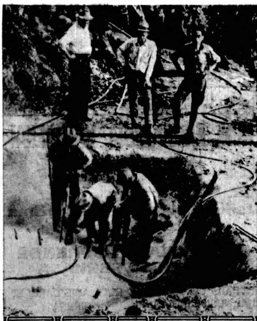
Cove Creek, Tennessee valst. prie susibėgimo Clinch ir Tennessee upių, pradėta statyti nauja Norris vartų užtvanka (dam.) Atvaizde parodoma pradedamieji darbai.
