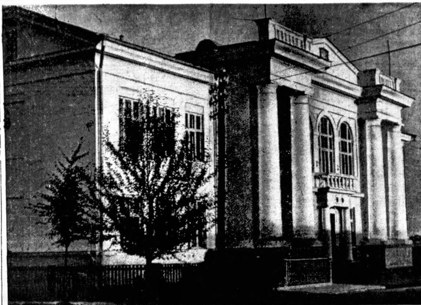
Naujieji Zarasai. Zarasų gimnazijos modernieji rūmai. (VDV).
