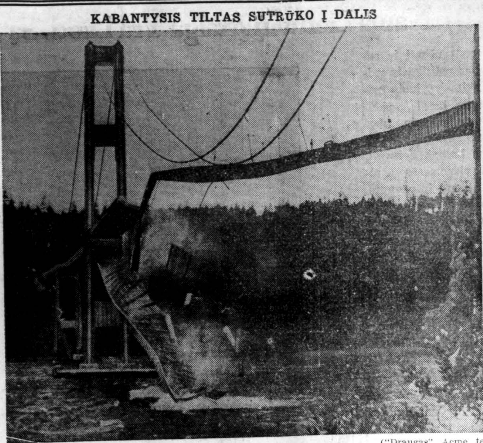
Kabantysis tiltas skersai Puget Sound, Tacoma, Wash., pastatytas 6,400,000 dol. Išsūmus, tomis dienomis neatsilaikė viesului, sutrūko į dalis ir susmuko į vandens gelmes. (Copyright Bashford-Thompson iš Aeme)
