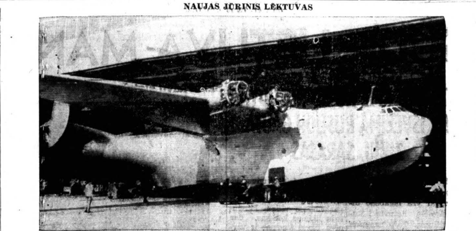
Martin dirbtuvėse pastatytas laivynui didžiausias pasaulyje jūrinis lėktuvas XPB2M. Yra 70 tonų. Sparnai užima 200 pėdų plotį. Sakoma, juo be sustojimo bus galima į abi puses perskristi Atlantiką. Martino dirbtuvės yra Baltimore, Md.
