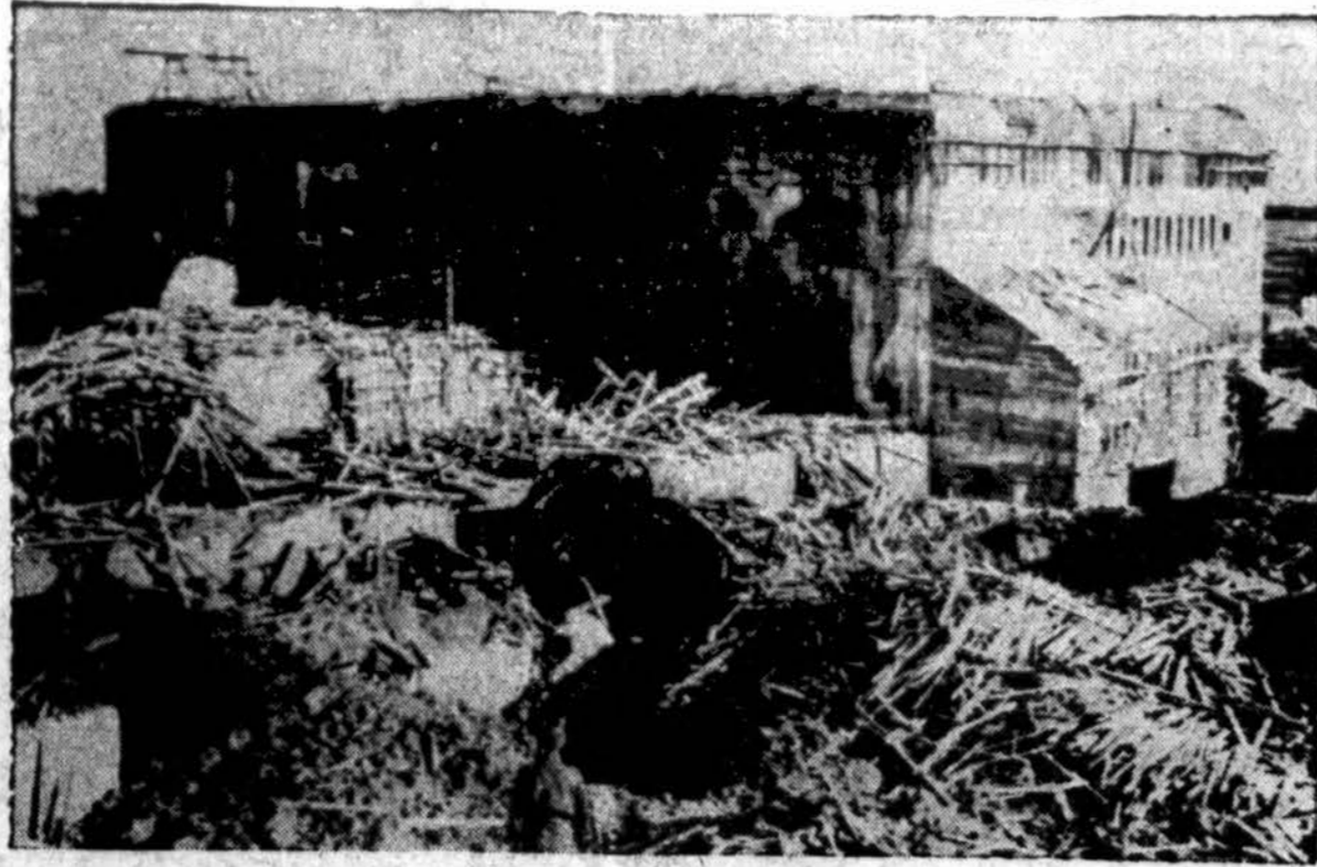
Nuotraukoj matome milžinišką betono (concrete) statybą netoli St. Omer, Prancūzijoje. Manoma, kad tai viena vietų, iš kurios naciai leido robotines bombas į Angliją. (Acme-Draugas telephoto)
