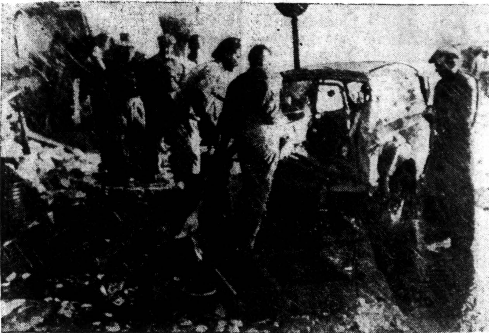
Žydų darbininkai išneša auką iš bombos sproginimo išaižytų griuvėsių vieno Tel Aviv pastato: po arabų lėktuvų atakos ant Izraelijos laikinosios sostinės. Vanduo iš trūkusių vamzdžių kliudo gelbėjimo veiksams. (Acme Telephoto)
