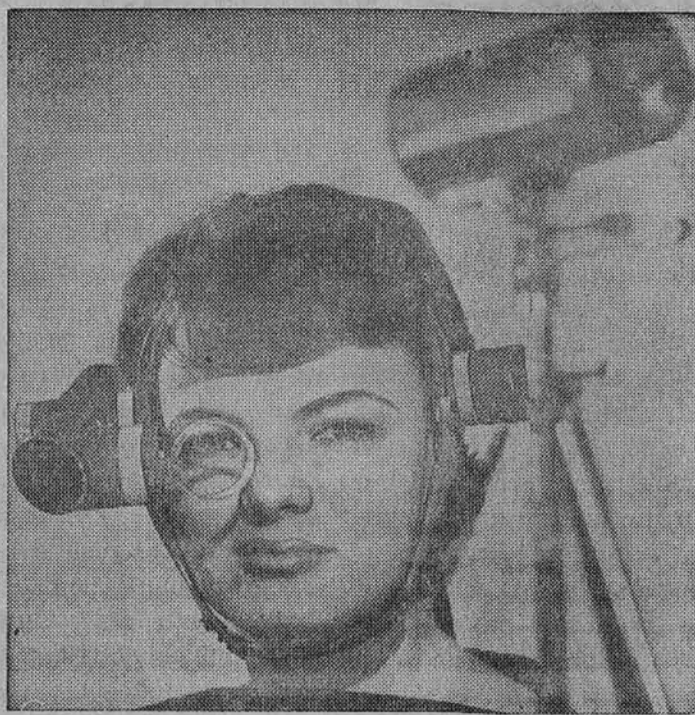
Demonstruojamas naujas aparatas vadinamas Electrocular, kurio pagalba galima matyti vaizdus, neatitraukiant akių nuo stebimo darbo, pavyzdžiui, skrendant lėktuvu galima matyti vaizdus per specialius prie akių pritaisytus diskus, neatitraukiant akių nuo vairavimo mechanizmo. Aparatus gamina Hughes Aircraft bendrovė Fullerton, Calif.
