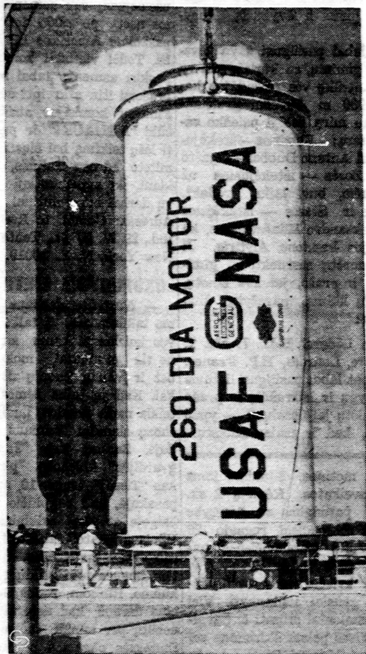
Aerofet darbuotojai Miami, Fla., stovi paruošta raketa 260 colių diametro ir turinti 3.5 mil. svarų kėlimo galios. Ji turėtų būti bandoma rugsėjo 25 d. Pilno pajėgumo panaši raketa turi 7 mil. svarų kėlimo galios, per vieną sekundę sudeginanti šešias tonas kuro.
