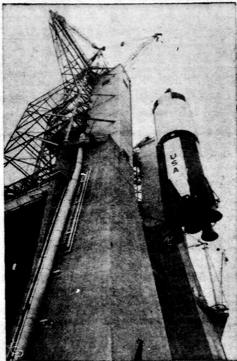
7.5 mil. svarų stumtis. — Pirmasis Saturno V stūmklis keliamas į bokštą būsimiesiems statiniams bandymams. 300.000 svarų stūmklis gali išvystyti 7.5 mil. svarų stumties jėgą. Stūmoklis stovi Marshall erdvės skriejimų centre Huntsville, Ala. Bent du statiniai bandymai bus atlikti pirmą kartą šio mėnesio pabaigoje.
