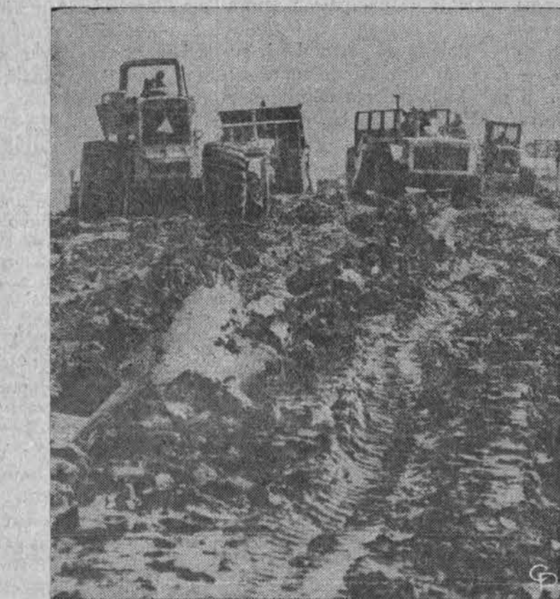
Netoli Mankato, Minn., stiprinamos krantinės, kad apsisaugotų nuo potvynių, kuriuos pavasariai sukelia Minnesota upė. Pylimas bus 37 pėdų aukščio.
