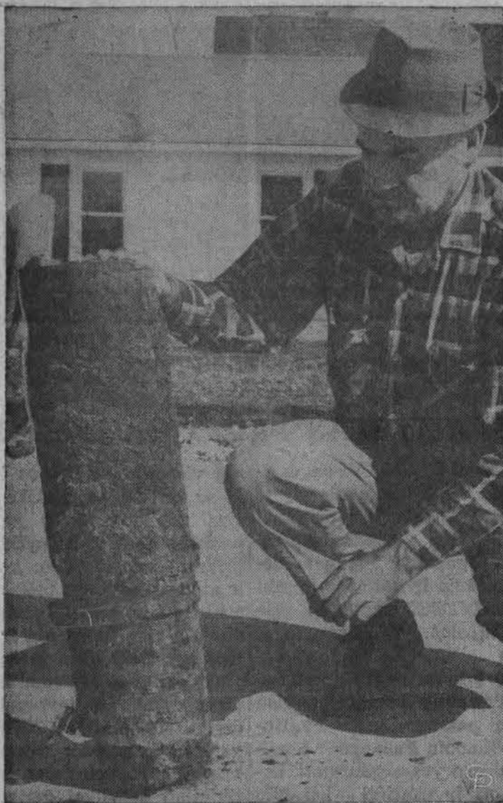
Olivet, Mich., miesto meras Kellogg laiko medinę pagrindinio vandentiekio dalį, kuri pakeičiama metaliniais vamzdžiais. Šie didieji mediniai vamzdžiai buvo mieste nuo 1900 m., kada buvo įvesta vandentiekio sistema.
