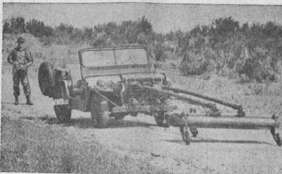
Amerikiečių armijos vyrai bando naują minų ieskijimo prietaisą San Diego, Calif. Naujasis prietaisas, pagamintas Ryan Aeronautical b-vės, yra labai patogus saugiai surasti paslėptas minas.
