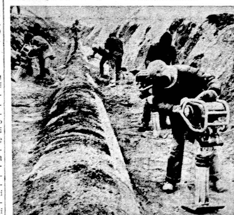
Šiuo metu Aliaskoje atliekami didžiuliai naftotiekio statymo darbai. Kai kur vamzdžiai iškelti gerokai virš žemės paviršiaus, kitur jie pakasami po žeme. Alyvos srovės greitis — 11 kilometrų per valandą
