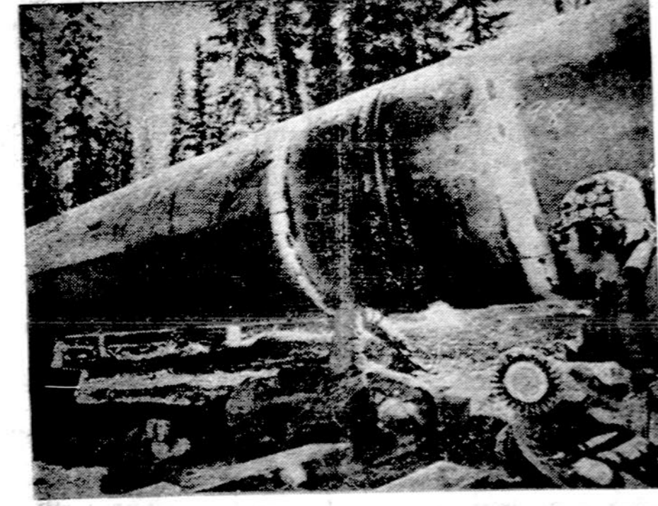
Alaskos naftotiekio tiesimo darbai. Vamzdžių suvirinimas ypatingai sunkus darbas
