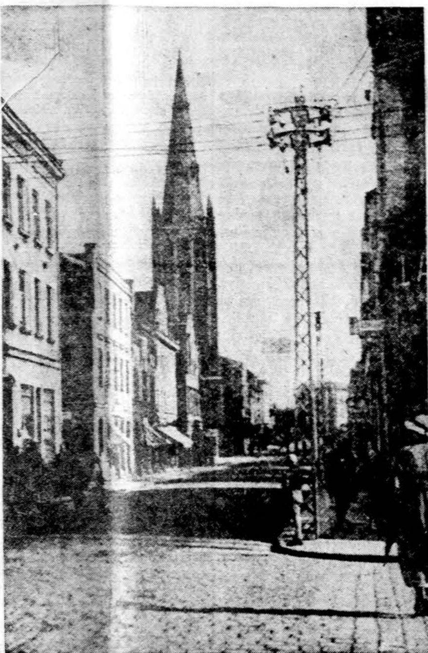
Klaipėda. Laukininkų gatvė su Reformatų bažnyčia
