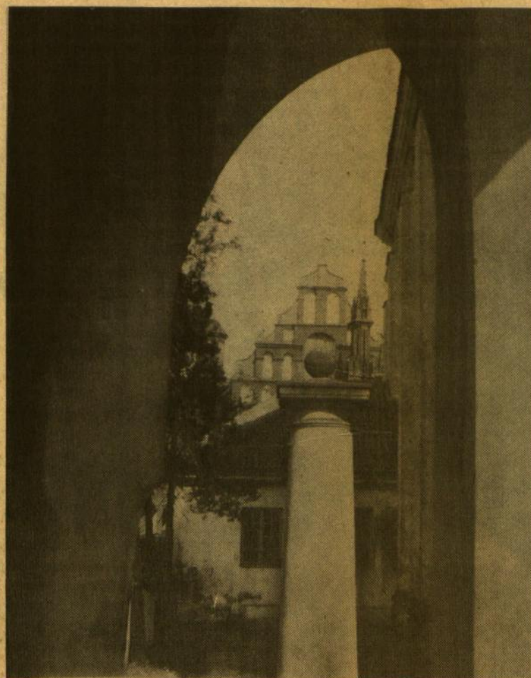
Sv. Mykolo bažnyčios Vilniuje šventoriaus fragmentas. Tolumoje — Bernardinų bažnyčios vakarinio fasado atkasa.
