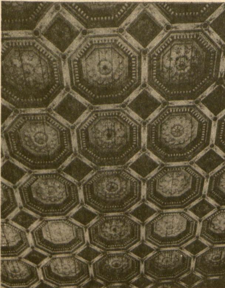
Evangelikų-reformatų bažnyčios Vilniuje lubų fragmentas, 19-asis amžius (architektas – Karolis Podčasinskis).
