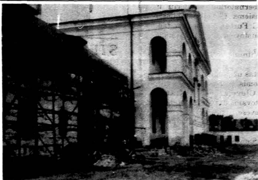
Pažaislio bažnyčios ir vienuolyno remontuojama dalis.
