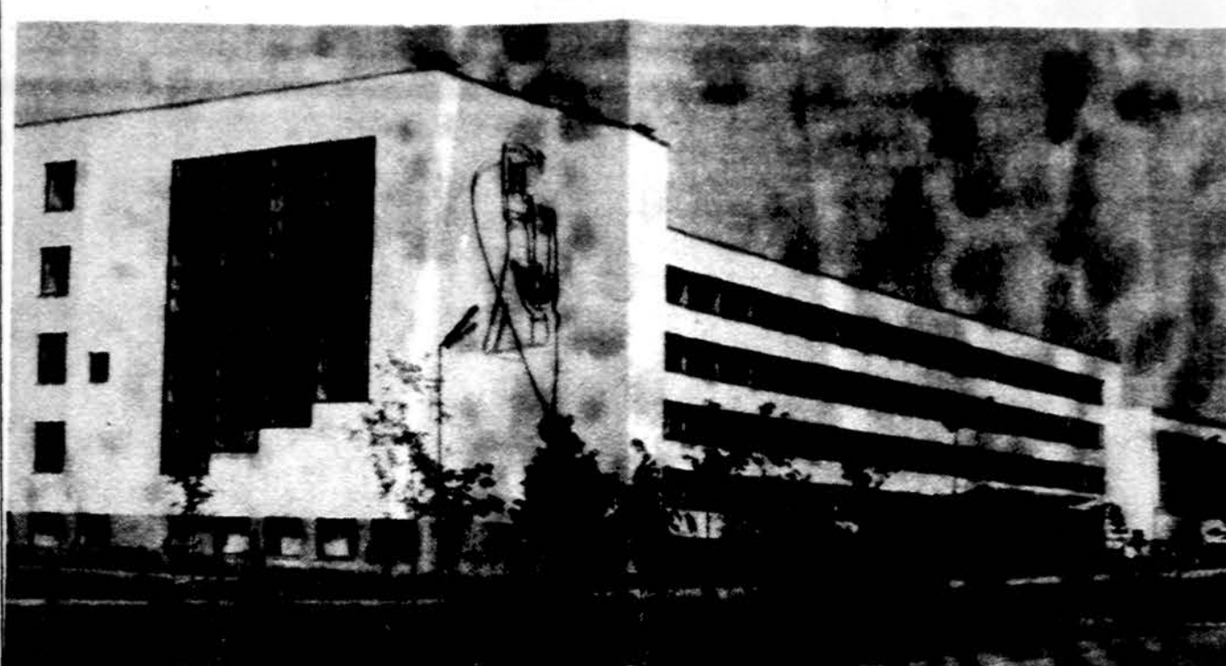
Technologijos universitetas Kaune, statybos ir santechnikos rūmai, projektuoti archt. V. Dičiaus.
