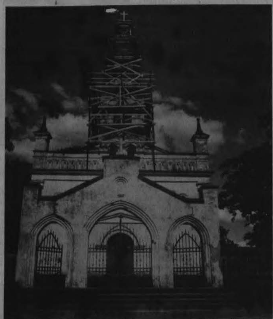
Žygačių bažnyčios (Žemaitijoje) bokšto remontas, kuriuo ypač rūpinasi parapijos klebonas kun. Alionidas Budrius.
