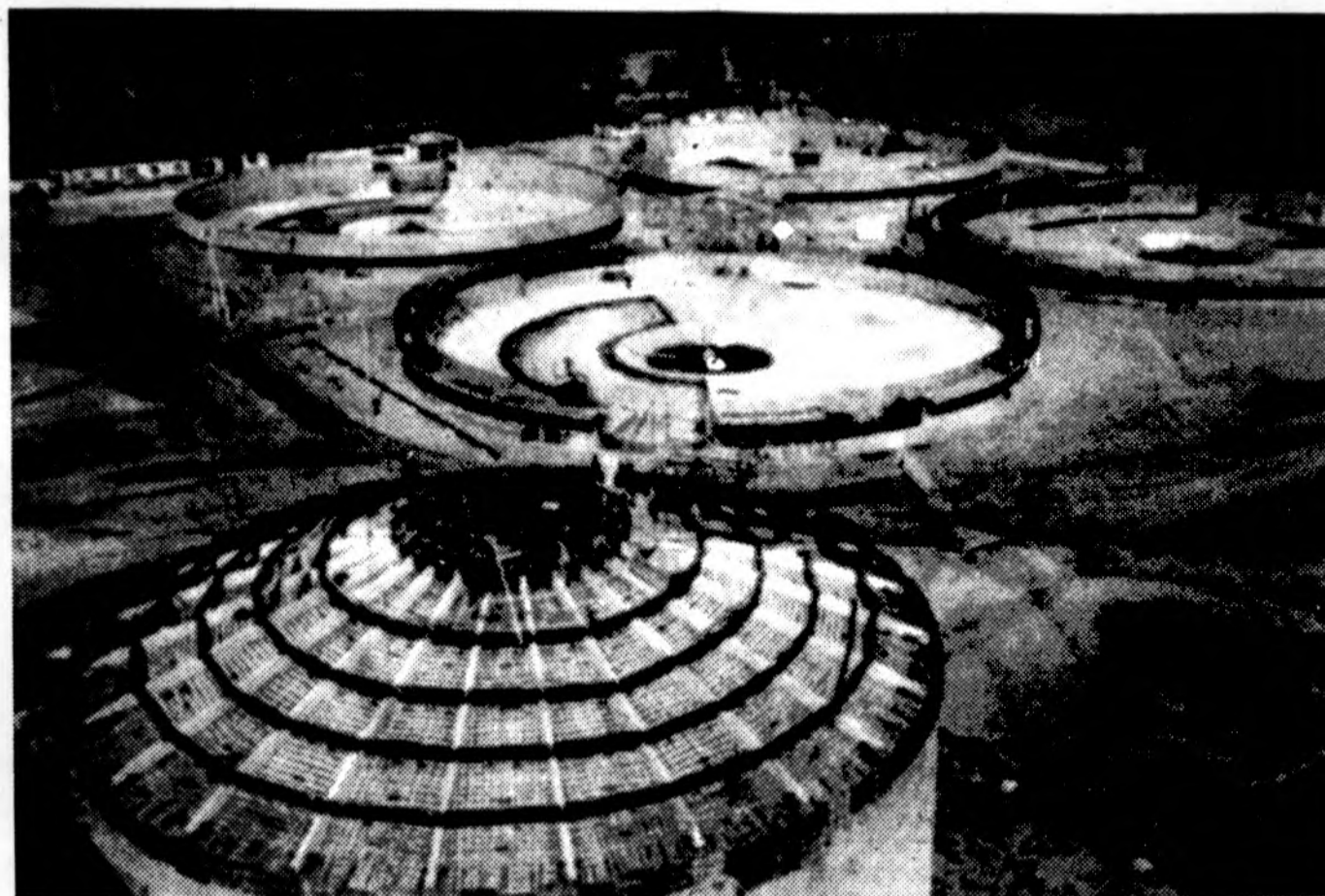
Šį rudenį sename Kauno priemesty Marvelėje prasidėjo naujosios Kauno vandenvalos įmonės statinių išbandymai. Nuotraukoje matyti didžiuliai dumblo nusodintuvai. Netoli jų aukštuose technologiniuose korpusuose išpuvęs dumblas bus specialiomis centrifugomis „nugręžiamas“ ir iš ten jau vežamas į kompostavimo poligoną. Kaip rašoma „Dienojė“, taip pat sparčiai statomas grotų bei smėliagaudžių korpusas, kuriame iš miesto vandenį bus pašalinamas smėlis, stambesnės atliekos ir nemalonus kvapas, kurį sugers specialūs medžio žieve užpildyti filtrai. Nuo statybos pradžios i šį projektą jau investuota apie 90 milijonų litų.
