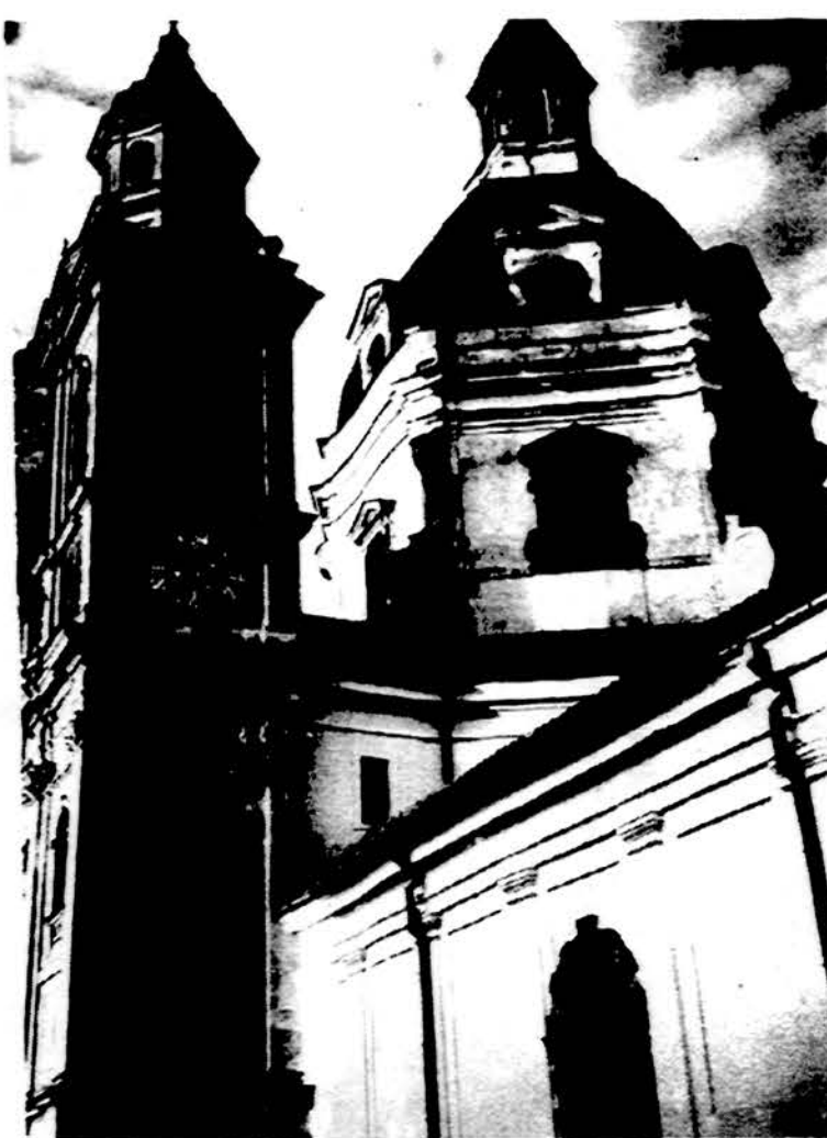
Pažaislio vienuolyno bažnyčios detalė 1996 m. vasarą. Nuotr. Liūdos Rugienienė
