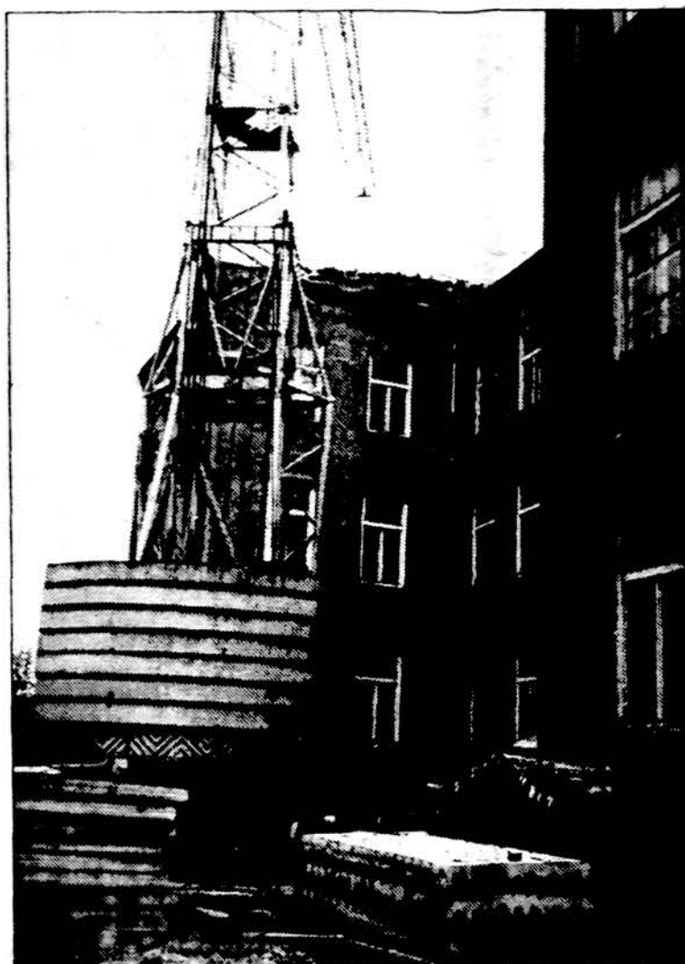
Remontuojama Marijonų gimnazija Marijampolėje. Tikima, kad jau ateinančių metų rudenį ji gales atverti duris moksleiviams, tačiau dar labai reikia lėšų, kad darbai būtų laiku užbaigti. Jeigu kas galėtų paaukoti šiam svarbiam tikslui, galima aukas siųsti kun. Viktorui Rimšeliui, MIC, „Draugo“ adresu, pažymint, kad tai Marijonų gimnazijos remontui.
