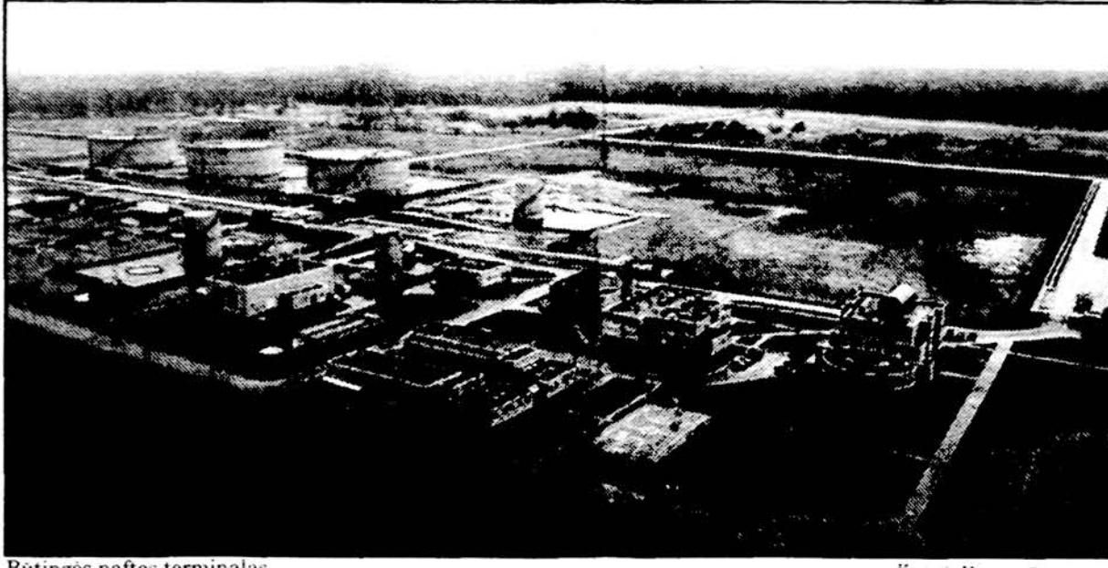
Butingės naftos terminalas.
