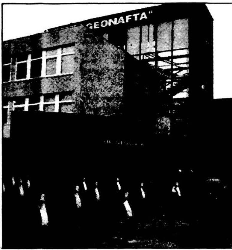
Naftos bendrovės „Geonafita“ ir „Minijos nafta“ administracinis pastatas Gargžduose. Kęstutis Vanago (Elta) nuotr.
