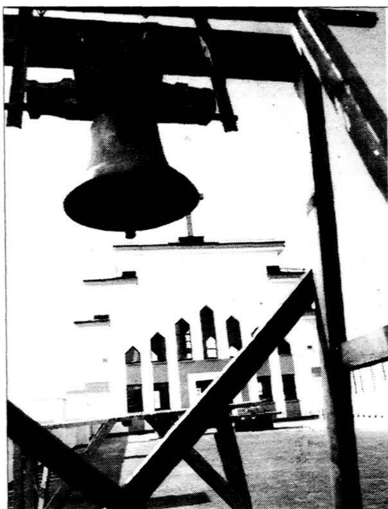
Remontuojamos Prisikėlimo bažnyčios detalė.
