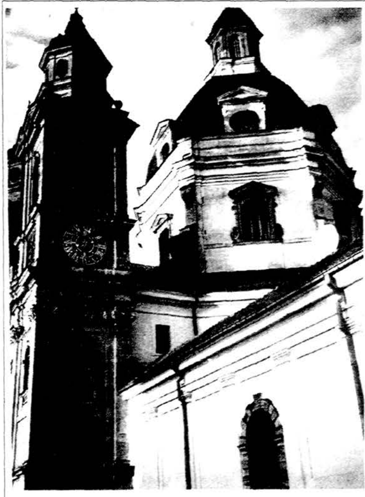
Pažaislio vienuolyno bažnyčios detalė 1996 m. vasarą. Nuotr. L. Rugienienė.
