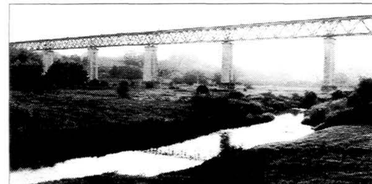
Lyduvėnų geležinkelio tiltas
