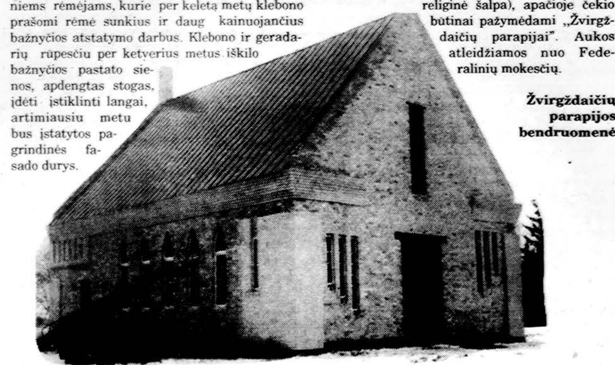
Švč. Jėzaus Širdies parapijos bažnyčia Žvirgždaičiuose – statybos darbai stumiasi pirmyn, bet trūksta lėšų juos užbaigti.
