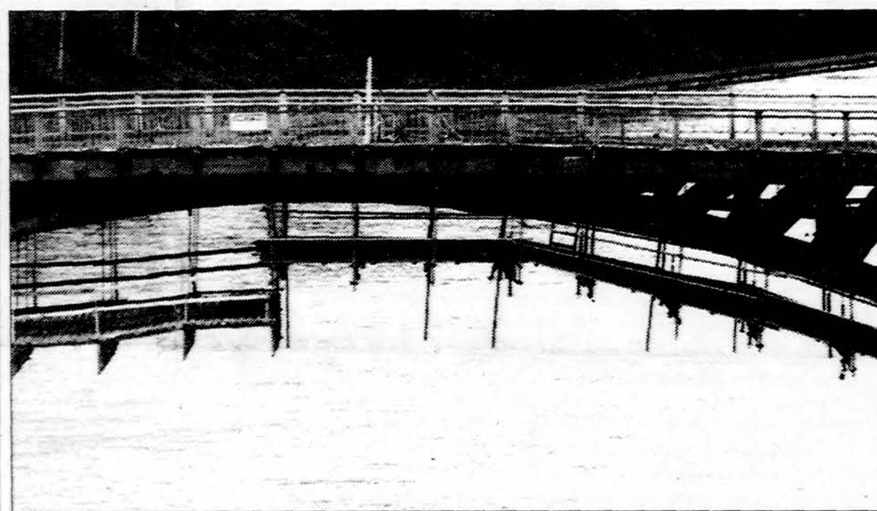
Vilniuje iki šių metų rugsėjo 1 dienos planuojama baigti kapitalinį Žvėryno tilto remontą. Numatoma bendra darbų kaina — 4,55 mln. litų. Tiltu remonto darbai jau atlikti už 1,65 mln. litų. Po juo sumontuoti pakabinami pastoliai ir pontonas, nuardytos tilto pakloto konstrukcijos, išpaunamos surūdijusios dalys, vyksta aukštos įtampos ir ryšių kabelių perjungimo darbai. Suremontuotą vieną seniausių sostinės tiltų papuoš pagal archyvuose išlikusius brėžinius atkurti autentiški turekliai ir žibintų formos šviestuvai. Eltos nuotr.
