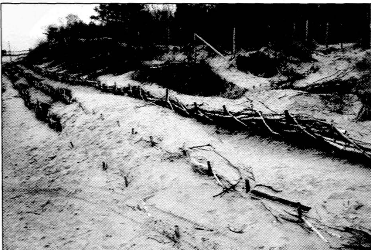
Kopos tvirtinamos žabtvorėmis ir šakų klojiniais. Gedimino Bartuškos (ELTA) nuotr.
