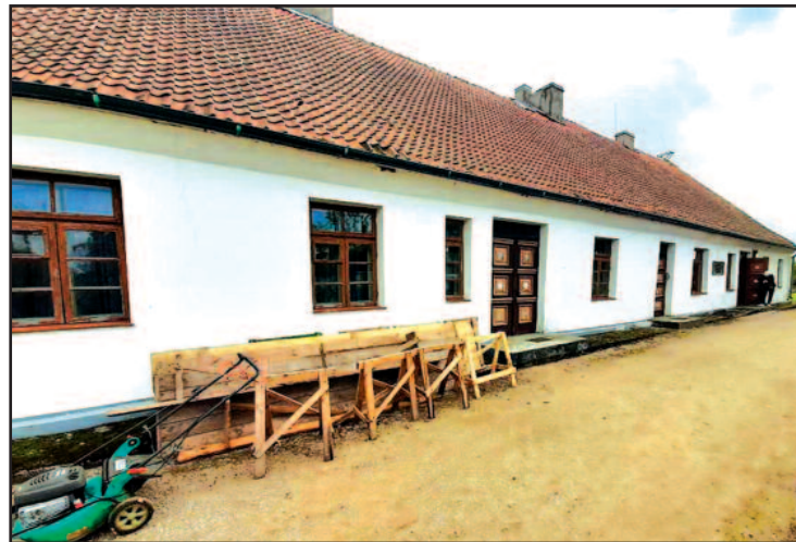
Buvusioje klebonijoje jau prasidėjo remonto darbai
