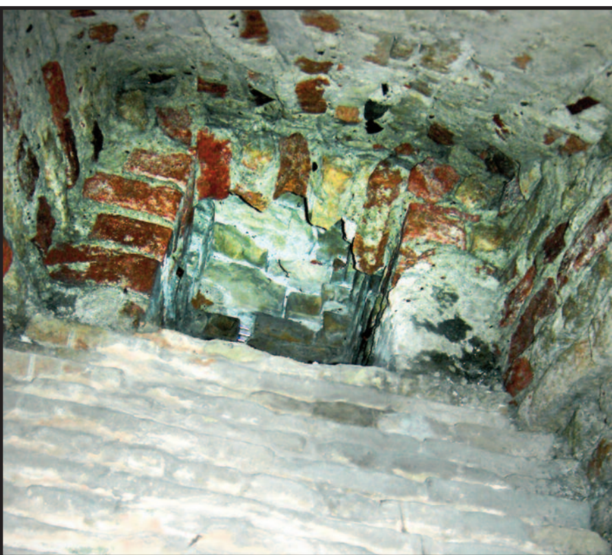
Atverta ventiliacijos anga, kuri išgelbėjo požemius nuo drėgmės ir pelėsio.
