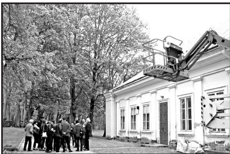
Remontuojamas Salų dvaras.
